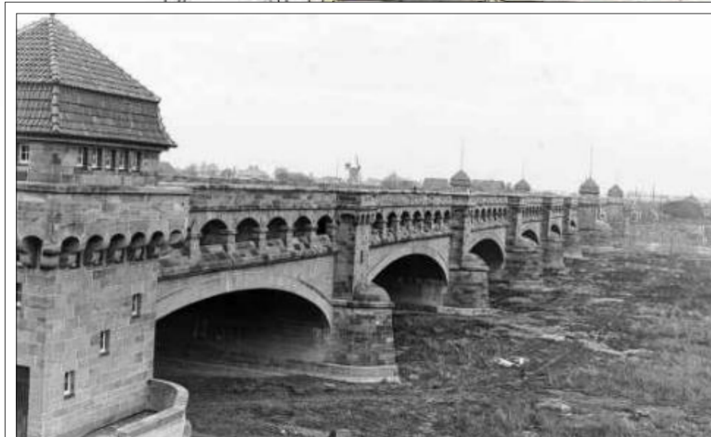
Weserüberführung im Dezember 1914 kurz vor der Freigabe
