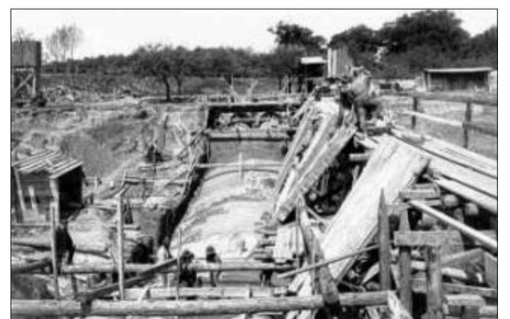
Düker für die Bückeburger Aue: Östlich von Minden ging der Bau durch Schaumburg-Lippe in Richtung Hannover weiter.
