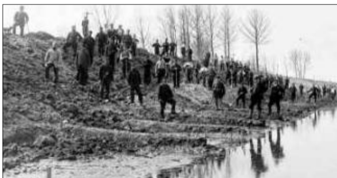
Nach Kriegsbeginn: Beim Weiterbau des Mittellandkanals kamen auch Kriegsgefangene unter Bewachung zum Einsatz.
