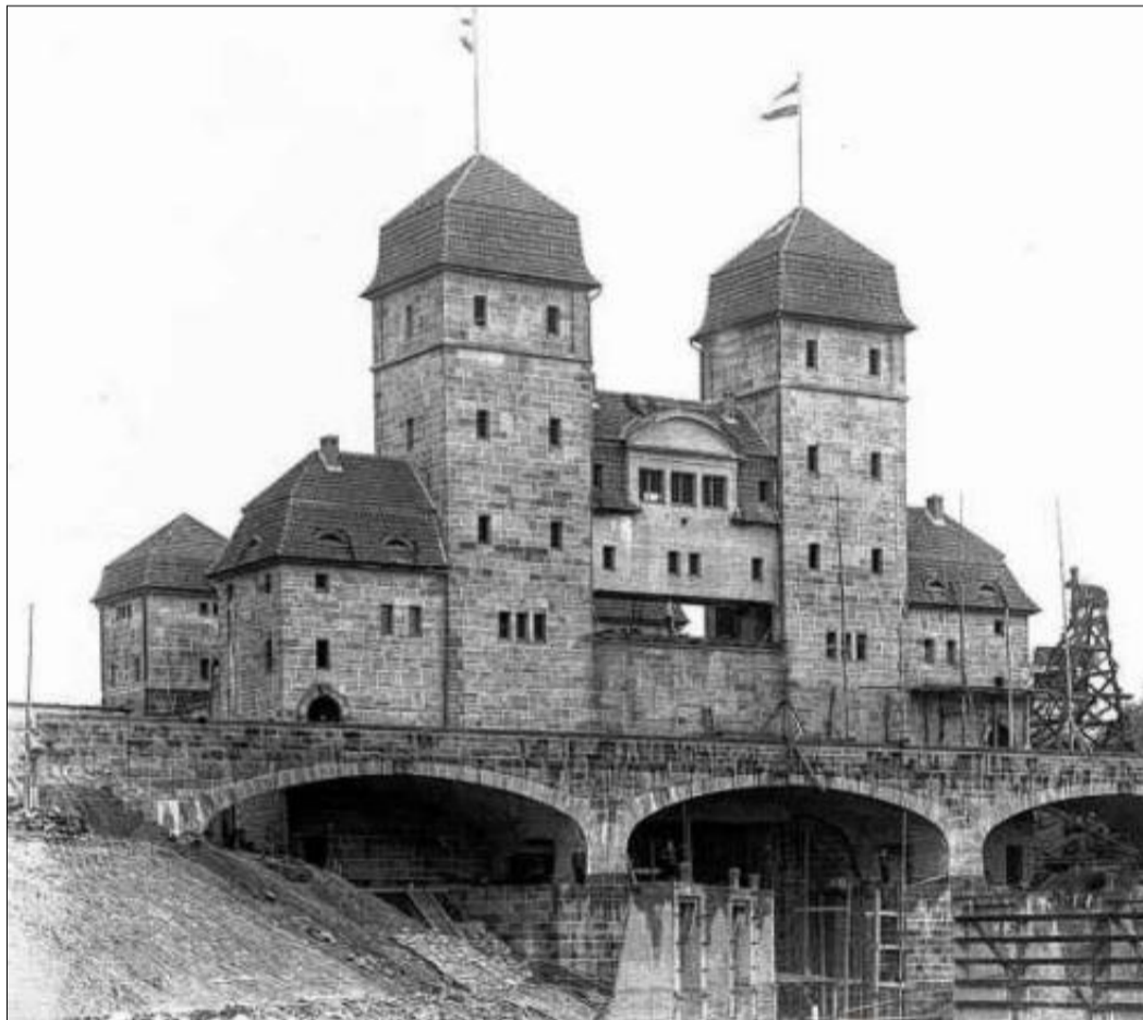
Monate vor der Fertigstellung: Im Mai 1914 war die Schachtschleuse schon klar als Wahrzeichen des technischen Fortschrittsglaubens im Kaiserreich zu erkennen, auch wenn es bis zur offiziellen Freigabe im Februar 1915 noch acht Monate dauern sollte. Fotos (Archiv): WSA
