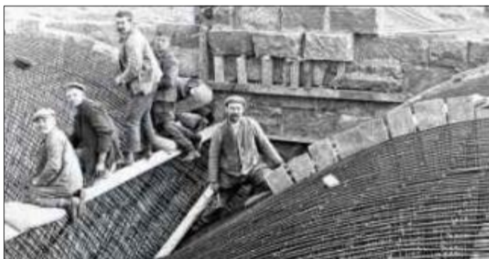
Die ersten Gastarbeiter: Spezialisten aus Italien arbeiteten als Eisenbieger für Rundbögen auf der Schleusenbaustelle.
