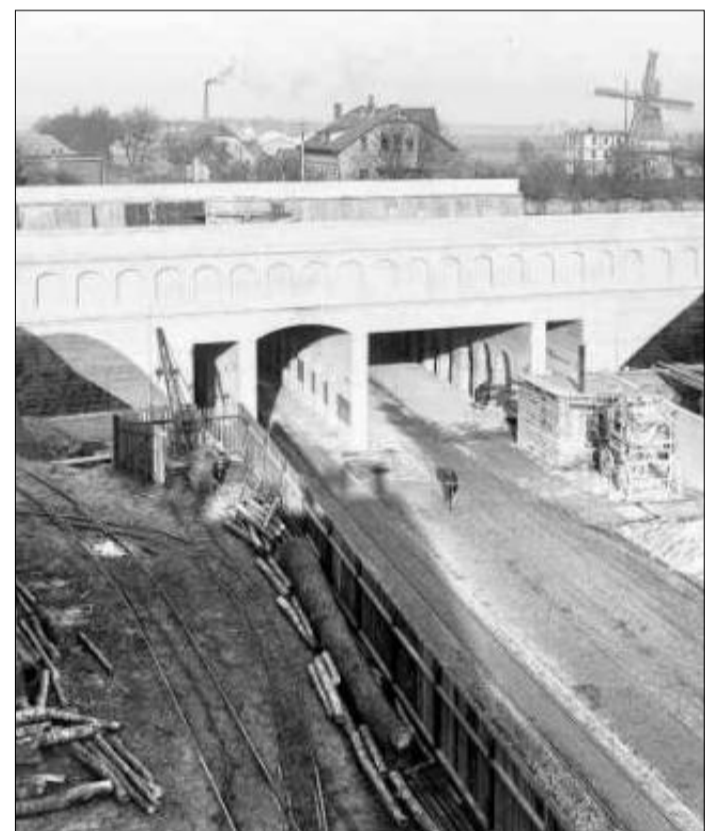
Unterführung: Die Friedrich-Wilhelm-Straße auf dem Ostufer wurde unter dem Kanal hindurchgeführt.
