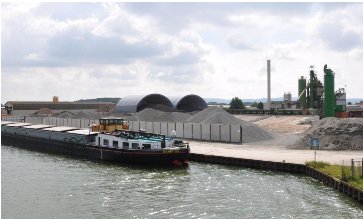
Fotos von oben nach unten: U.L.L.A. GmbH Agrar-Logistik Standort Minden einschl. Ölmühle Minden GmbH im Gebäudezusammenhang (Weser Abstiegshafen Minden). Johann Bunte Bauunternehmung GmbH & Co. KG Asphaltmischwerk Preußisch Oldendorf-Getmold (Mittellandkanal).
