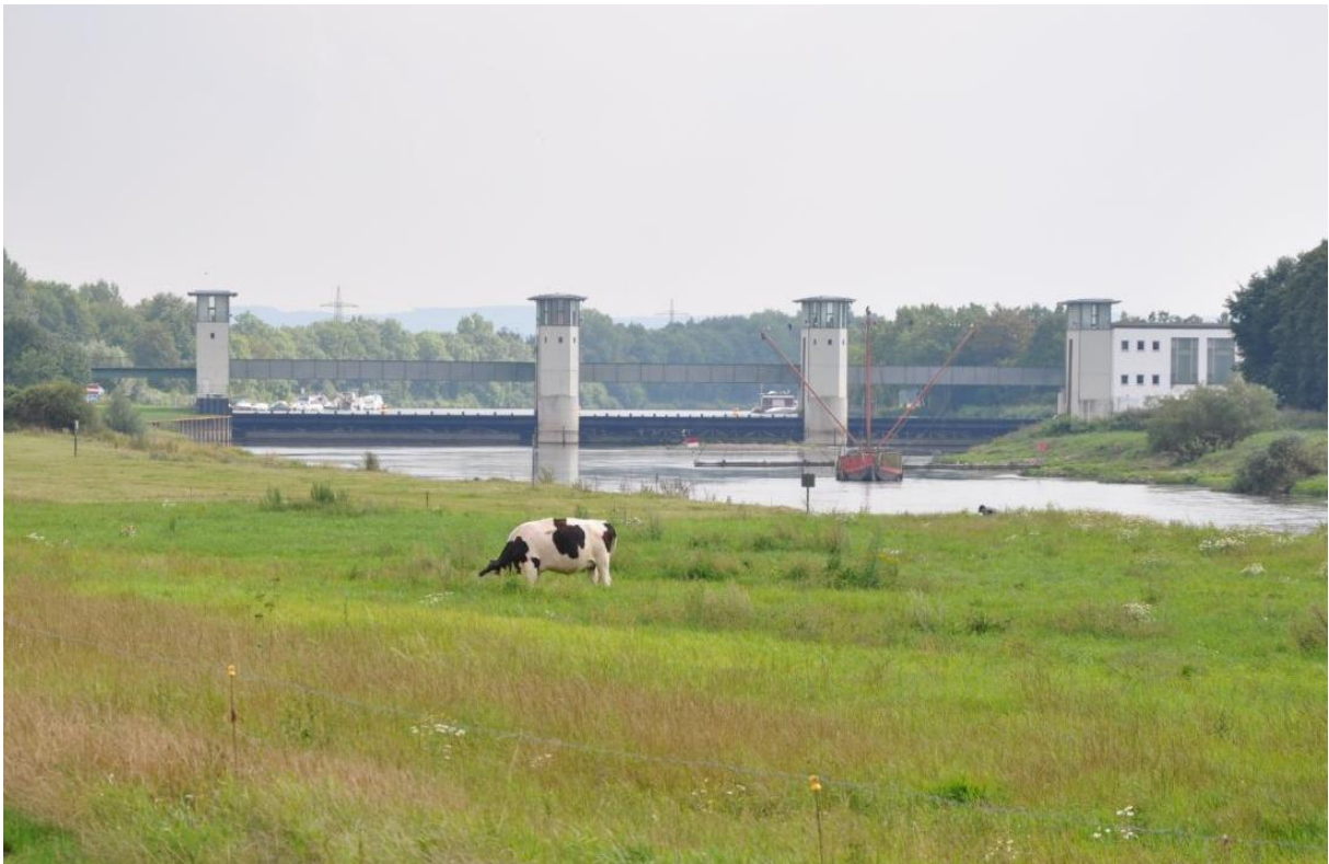
Fotos von oben nach unten: Laufwasserkraftwerk Schlüsselburg mit Aalfänger im Vordergrund. Laufwasserkraftwerk Petershagen mit Aalfänger im Vordergrund.
