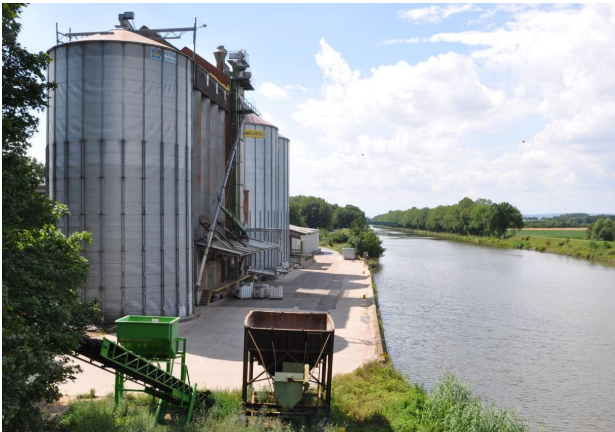
Foto: RLB Raiffeisen-Landbund eG Betriebsstätte Petershagen-Lahde, Weser.
