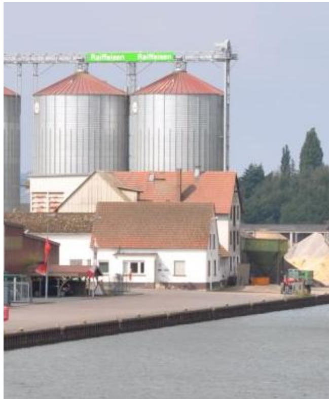
Fotos von oben nach unten: Getmolder Hafenumschlag Lager und Transporte GmbH & Co. KG. Raiffeisen-Markt Stemweder Berg GmbH Standort Preußisch Oldendorf-Getmold. Beide Mittellandkanal.
