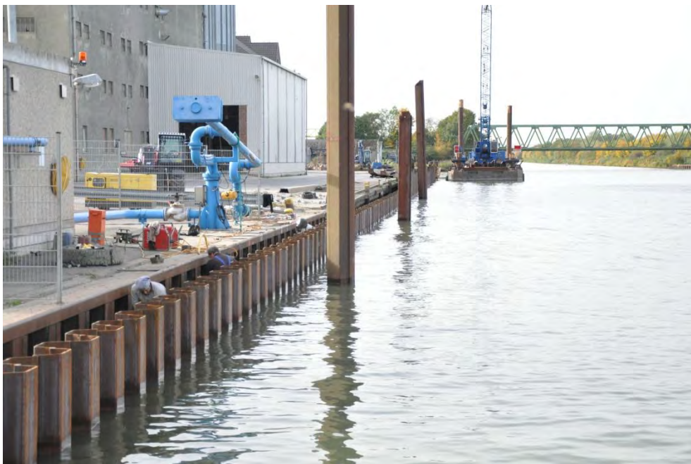
Foto: Bauarbeiten im Lübbecke-Hafen (Oktober 2012).
