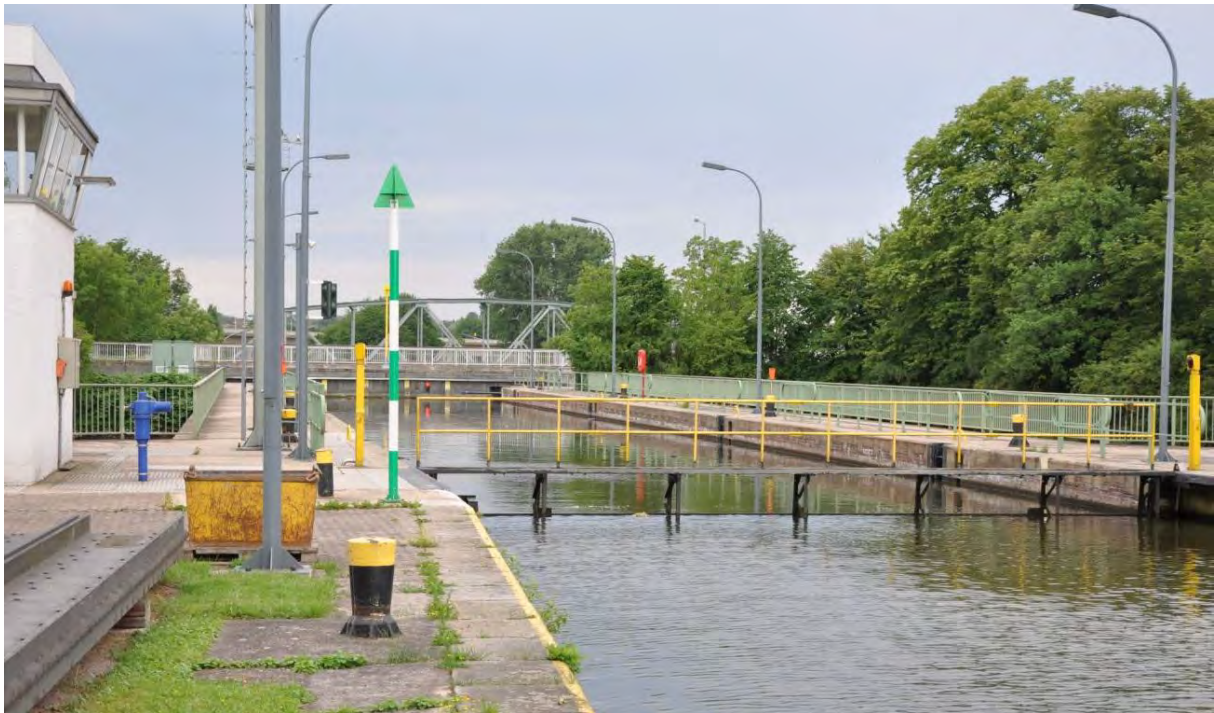
Foto: Untere Schleuse Minden zwischen Industriehafen Minden und Weser.
