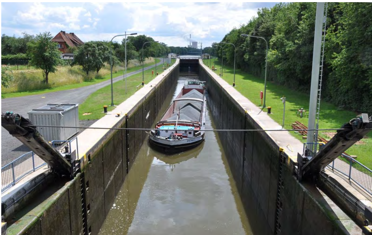
Fotos von oben nach unten: Schleuse Schlüsselburg. Schleuse Petershagen.
