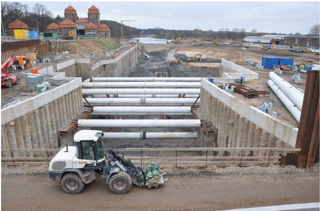
Foto: Schleusenbaustelle am Wasserstraßenkreuz Minden und links hinten die bestehende Schachtschleuse (13. März 2012).
