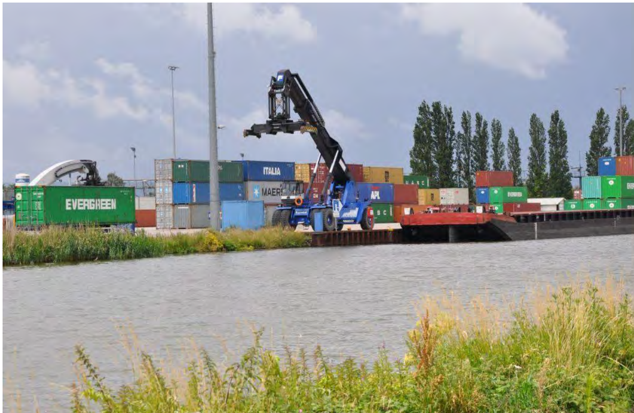
Foto: Trimodale Umschlagsanlage Minden Industriehafen.
