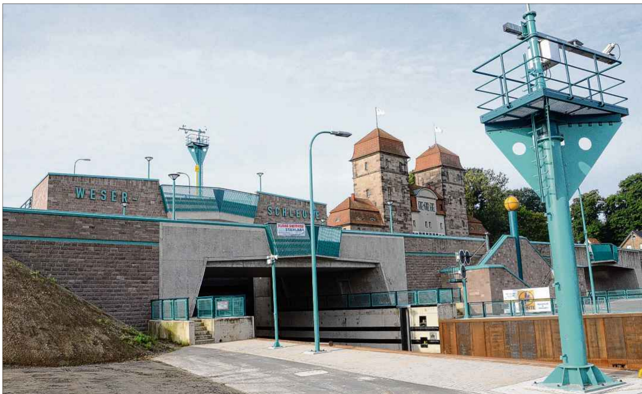
Zwei Jahrhundertbauwerke nebeneinander: Die neue Weserschleuse wird nach siebenjähriger Bauzeit heute eröffnet. Die Schachtschleuse ist seit dem 16. Februar 1915 in Betrieb. Türkis ist die Erkennungsfarbe der Bauwerke am Wasserstraßenkreuz, die gelbe Kugel tritt auch an der Kanalüberführung in Erscheinung. MT-Fotos: Langenkämper
