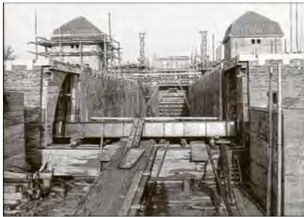
Wichtiger Schritt: Anfang Dezember 1913 wurde das obere Schleusentor eingebaut.
