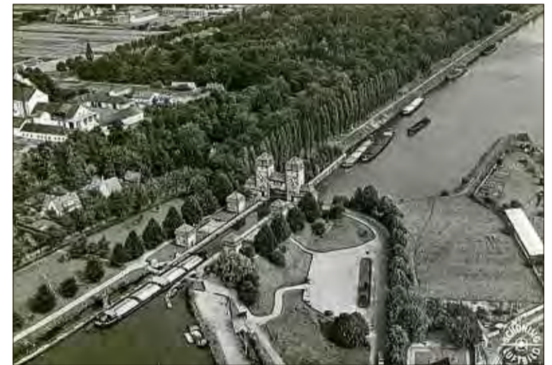
Vogelschau: Oberhalb der Schleuse befand sich die Brauerei Feldschlößchen (links). Am Parkplatz (rechts) war noch kein Kiosk gebaut.
