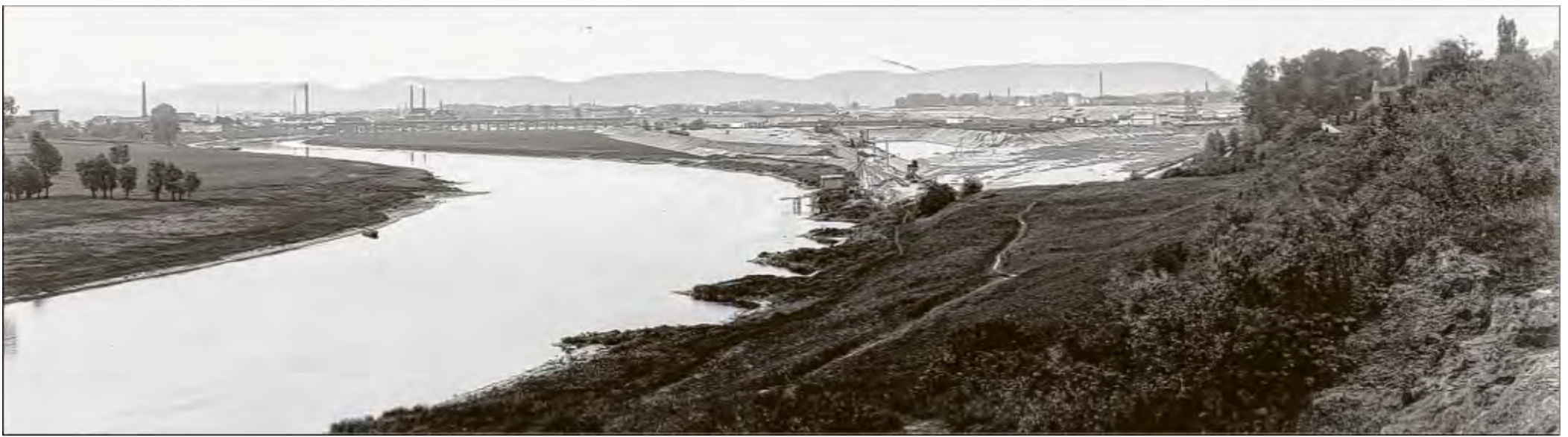
Blick auf die Baustelle im Juni 1912: Die Becken des unteren Vorhafens und des Abstiegshafens mussten erst ausgebaggert werden. Im Hintergrund ist bereits die Kanalbrücke zu sehen und in der Ferne das Wesergebirge. Die Baustelle der Schachtschleuse ist hinter den Bäumen am Hochkreuz des Nordfriedhofs (rechts) halb verborgen. Fotos (Archiv): WSA Minden
