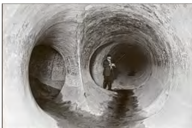
Riesige Kanäle: Mehr als mannshoch ist der Umlauf, in den von links ein Ventilschacht einmündet.
