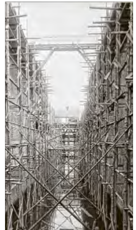
Blick vom Oberhaupt in die Schleusenkammer: Für Maurer stehen Gerüste.
