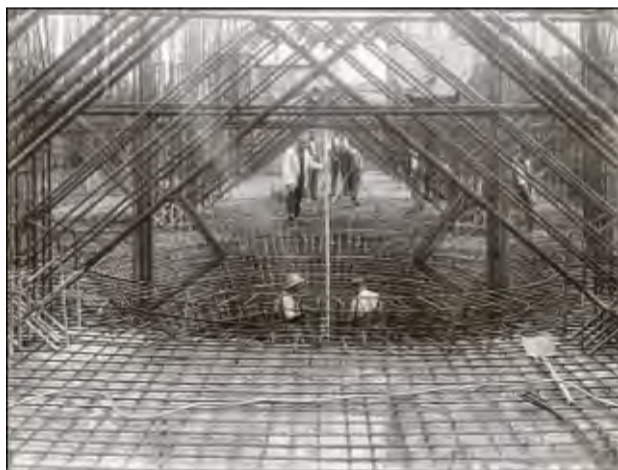
Sparbecken: Im Stahl für die Bewehrung der Sohle und der Binder erscheinen die Arbeiter 1912 wie Zwerge.
