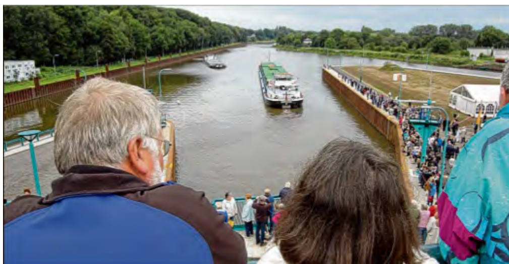
Geschafft: Die „BCF Glückauf“ aus Haldensleben ist mit 36 Doppelcontainern als erstes Schiff geschleust worden – und ein weiteres wartet schon. MT-Fotos: Langenkämper
