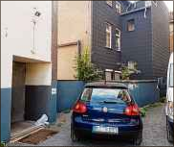
Hinterhof: In der Lücke links würde der Fahrstuhl enden.
