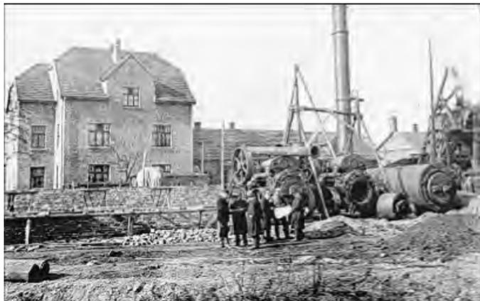
Riesige Dampfmaschinen sorgten durch die Entwässerung der Flöze für die Sicherheit der Kumpel unter Tage.
