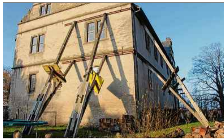
Seit mehr als drei Jahrzehnten sichern Pfeiler und Stahlträger den Giebel des Ostflügels vor dem Absturz.
