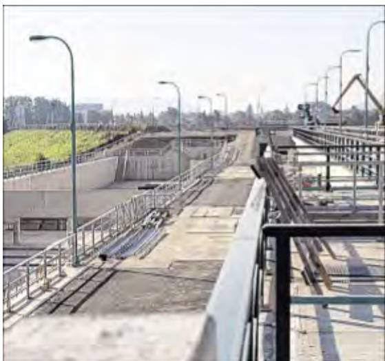
Nach und nach leert sich die Baustelle, jetzt laufen Funktionstests. Hier ein Blick auf die Sparbecken.
