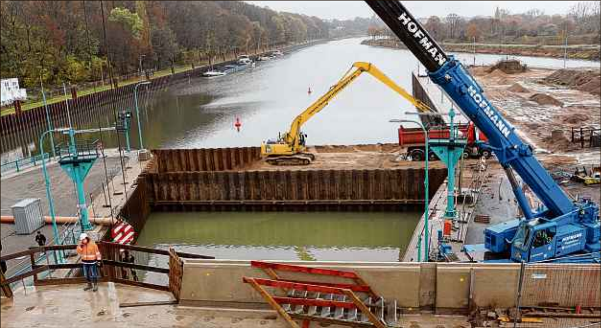
Arbeiten am Fangedamm: Ein Bagger holt die Erde aus dem Dammbereich zwischen den Spundwänden heraus. Noch trennt der Fangedamm das Vorbecken vom Vorhafen. Bis Weihnachten ist er verschwunden.
