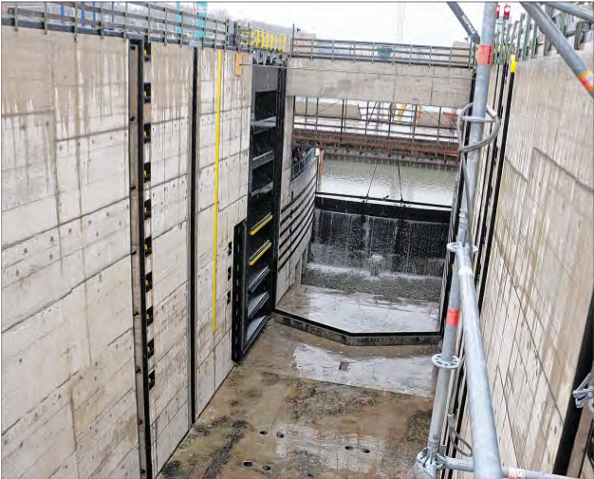
Das erste Weserwasser: Ein Kran hebt die oberste Verschluss­tafel an, und Wasser strömt aus dem Vorbecken in den Zulauf vor den noch geöffneten Schleusentoren. Fotos: Alfred Loschen
