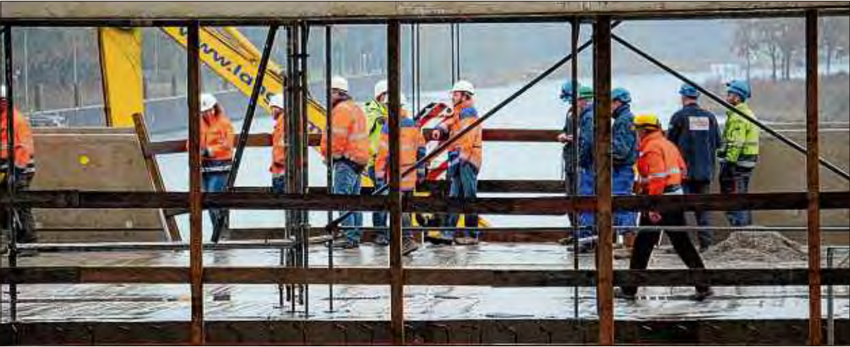
Gespannt: Mitarbeiter der Bau­firmen warten auf der Brücke vor dem Unterhaupt darauf, dass die Revisionsverschlusstafel gezogen wird und Wasser in den Schleusenzulauf strömen kann.
