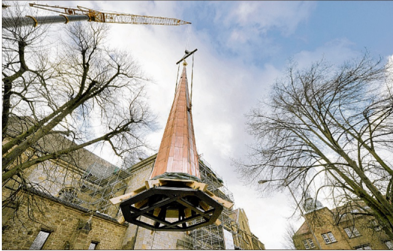
Im Dezember 2011 wurde die Haube auf den neuen Vierungsturm gesetzt. Eine integrierte Stahlwanne unter dem Turm würde den Dom im Ernstfall besser schützen. Foto: MT-Archiv/ Manfred Otto
