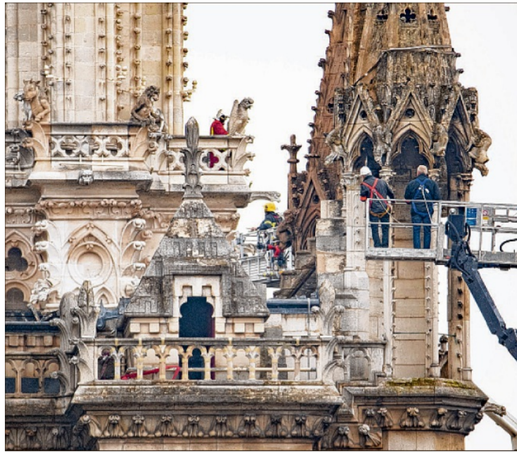
Feuerwehrleute und Spezialisten begutachten das Dach von Notre-Dame. Bevor das Innere der Kathedrale betreten werden kann, muss es begutachtet werden. Foto: Marcel
